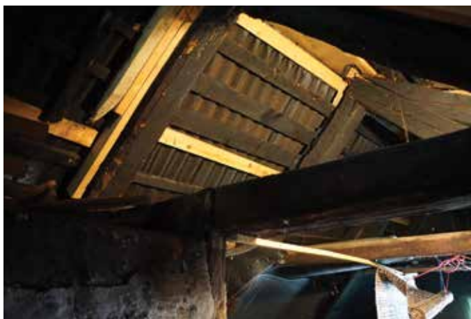
Obstoječe stanje notranjosti hiše U malnu
